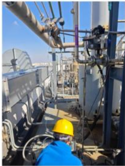
S#806 车间酸性有机废气进口
